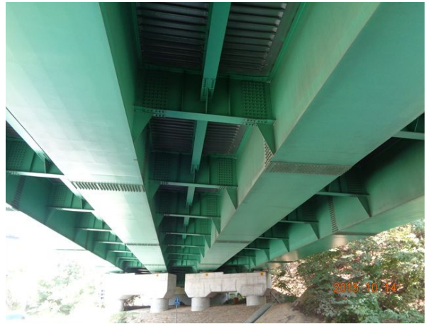
바닥판 및 거더 전경
