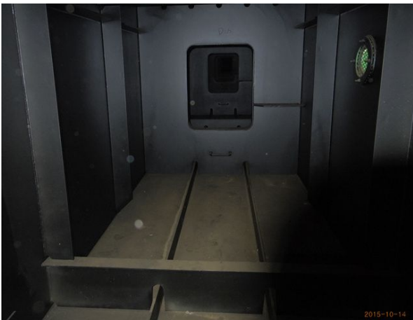
거더 내부 전경
